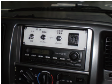
コントロールパネル (キャビン)
