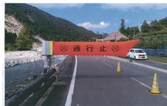
危険渓流に設置した土石流センサが破断した場合、即座に関係各所へ警報メールを発信するとともに、土砂が道路にまで達した場合の事故を防ぐためエア遮断機を動作させることができるシステムです。
